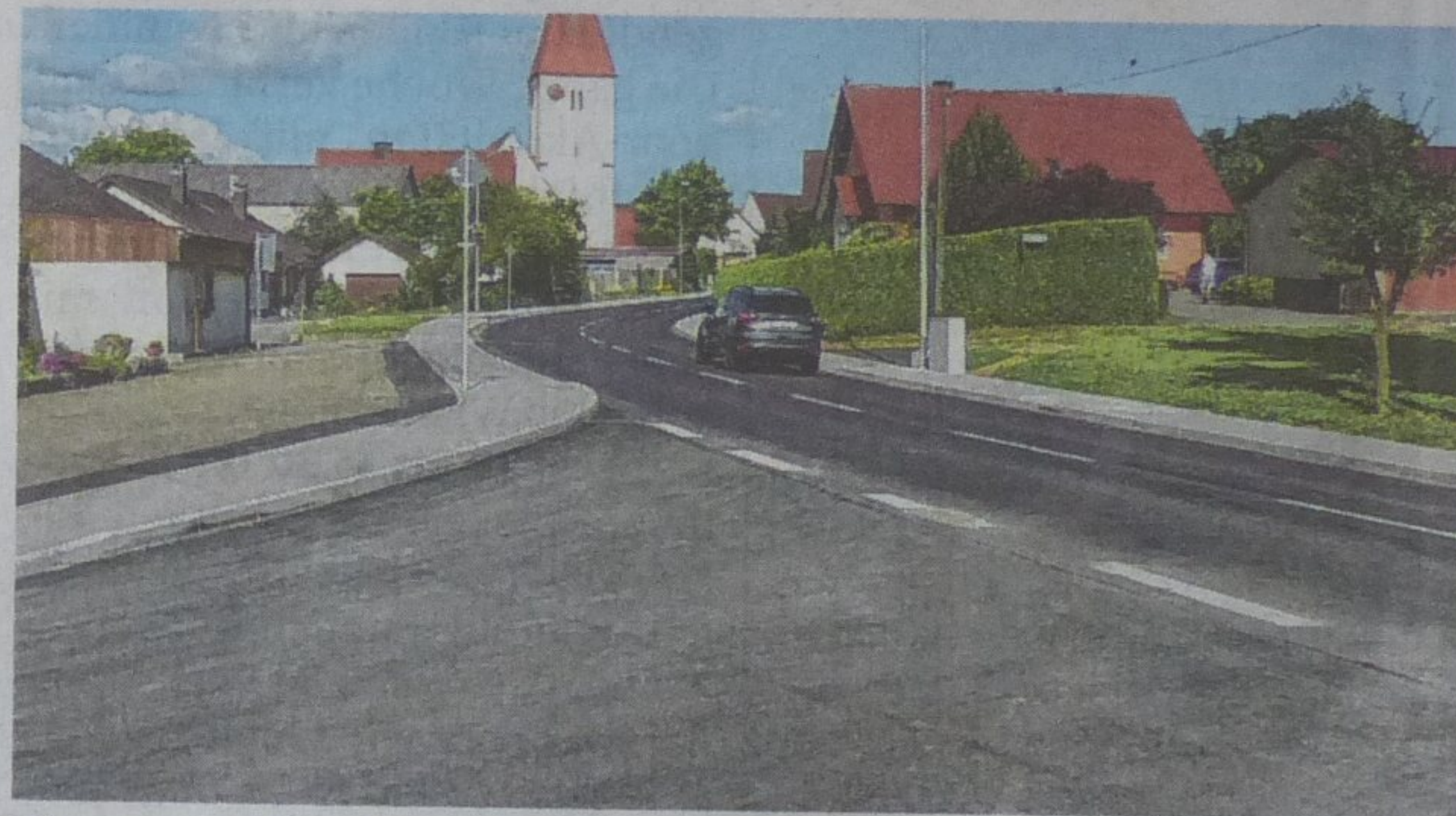
Die „neue“ Ortsdurchfahrt Benzenzimmern.
